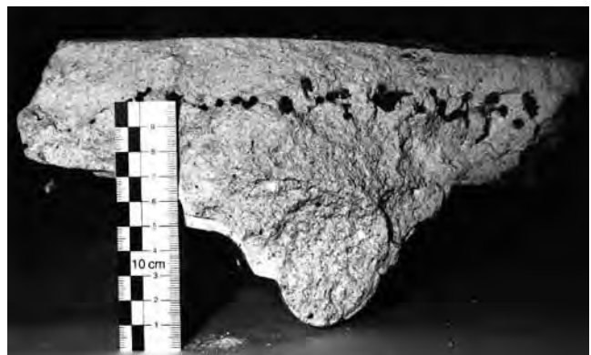
Abb. 31: Herrenhausen, Galeriegebäude, Reststück bei der Wiederherstellung nach dem 2. Weltkrieg
