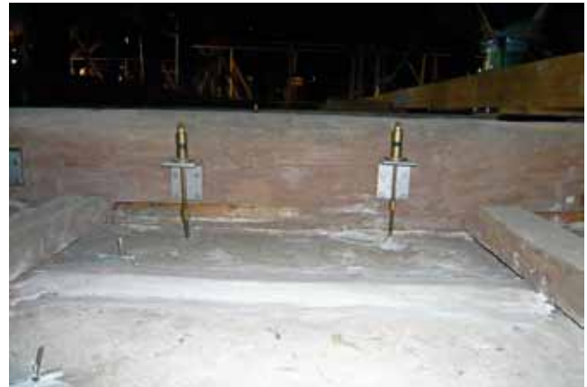
Abb. 33: Herrenhausen, Galeriegebäude, ausgeführte Feder-Sicherung, links Typ A einer Verankerung im Stuckprofil, rechts Typ B einer Verankerung in der Putzschicht mittels kunststoff-modifiziertem Gips-Mörtel
