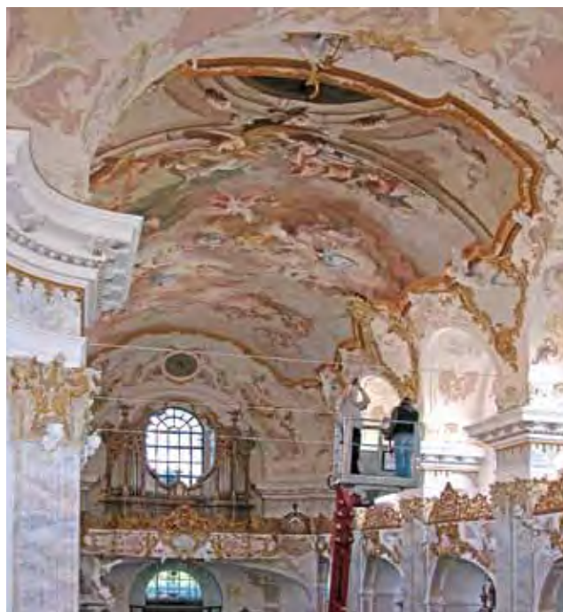
Abb. 1: Fürstenzell, Klosterkirche, Untersuchung der Gewölbeuntersicht vom Hubsteiger aus
