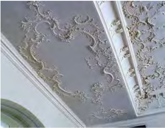
Abb. 5: Schloss Veitshöchheim, Weißer Saal, rekonstruierter Deckenteil, Ostseite (2003)
