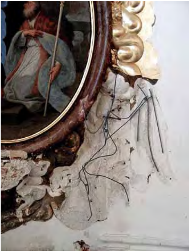
Abb. 8: Lustheim, Renatuskapelle, Gerüst und Umriss der historischen Figuren unter dem und an der rechten Seite des Altarbildrahmens, noch ohne Japanpapiertrennung
