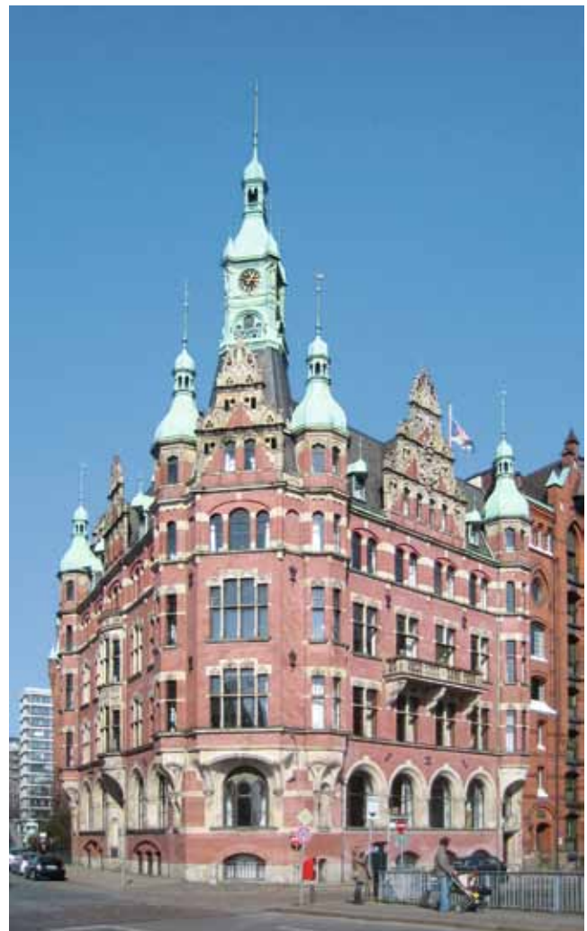
Abb. 10: Das zweite Verwaltungsgebäude der HFLG von Hanssen & Meerwein und Johannes Grotjan (1902–04)
