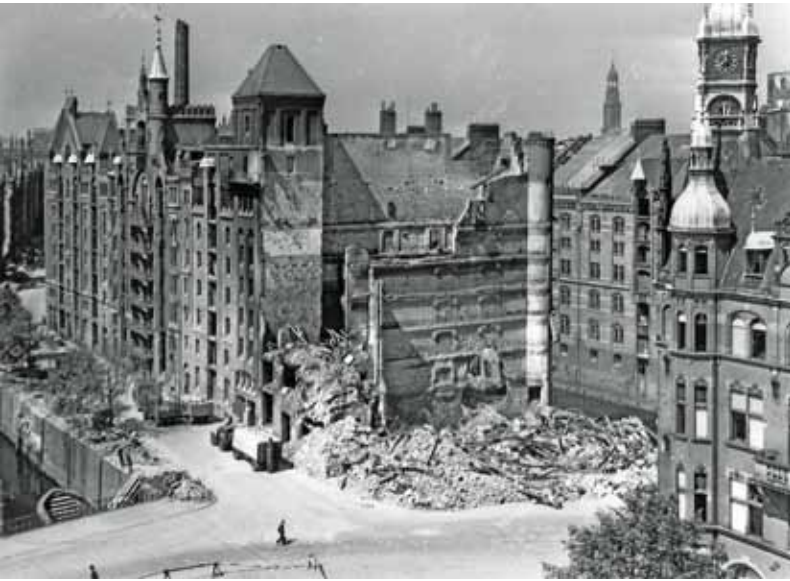
Abb. 11: Die Ruine von Block R (1944)
