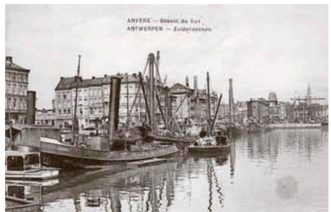
Abb. 4: Das 1882 angelegte, 1967 verfüllte „Zuiderdok“, im Hintergrund die monumentale Hydraulik-Zentrale
