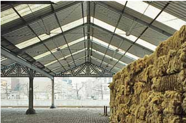
Abb. 9: Die eisernen Lagerschuppen entlang des 1877–1988 erbauten Scheldekais
