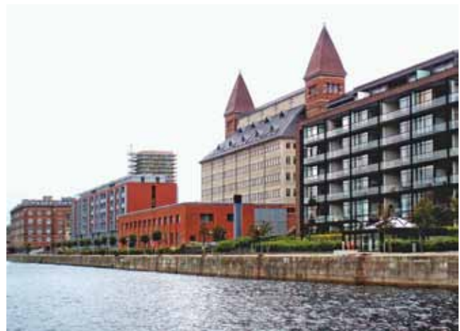
Abb. 12: Neu- und Altbauten auf dem Amerikakai; in der Bildmitte das umgebaute ehemalige Silo Lagerhaus von Levy (auch „Domkirche des Freihafens“ genannt) (2007)
