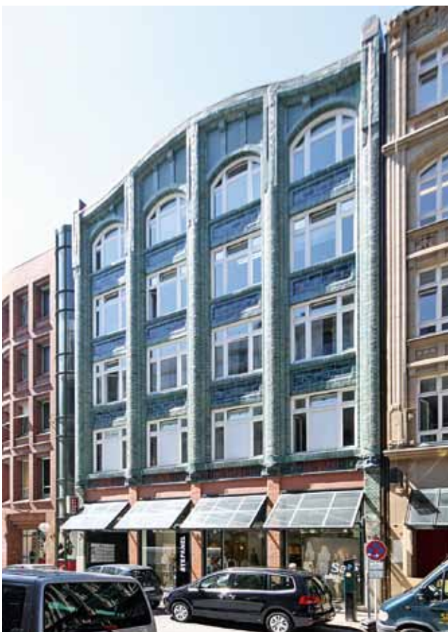
Abb. 8: Alsterhaus, Rückfront, 1902–03, Architekt Albert Erbe
