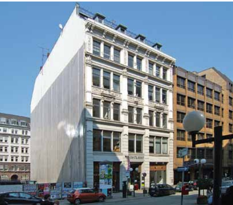
Abb. 4: Burstahhof, 1887–88, Architekten Bahre & Querfeld
