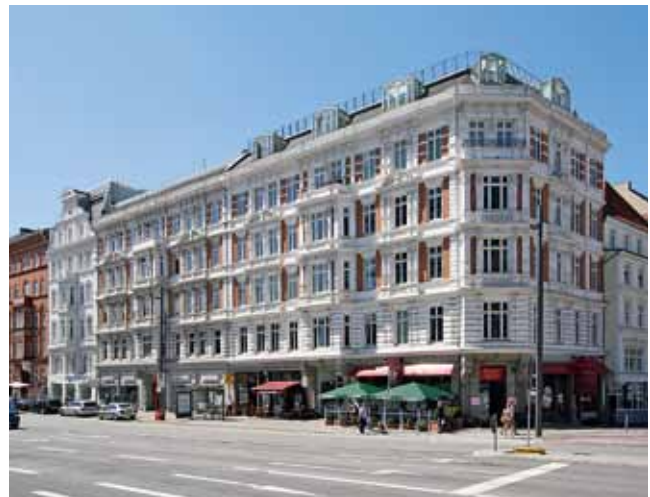
Abb. 3: Wohn- und Geschäftshaus Brandstwierte, 1886–87, Architekt Albert Heidtmann
