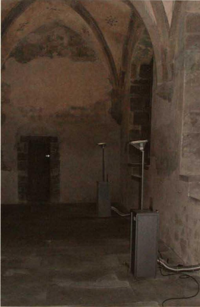
Abb. 5. Maulbronn, Kloster, Dormentbau, Laienrefektorium: Lüftergehäuse für den Dauerbetrieb mit Integration funkbasierter Messbaugruppen.
