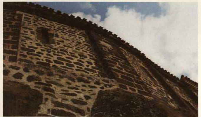
Fig. 24. Saint-Michel d'Aiguilhe, Joint system of the basaltic tuff masonry / Michaelskapelle, Fugensystem des basaltischen Tuffmauerwerks.
