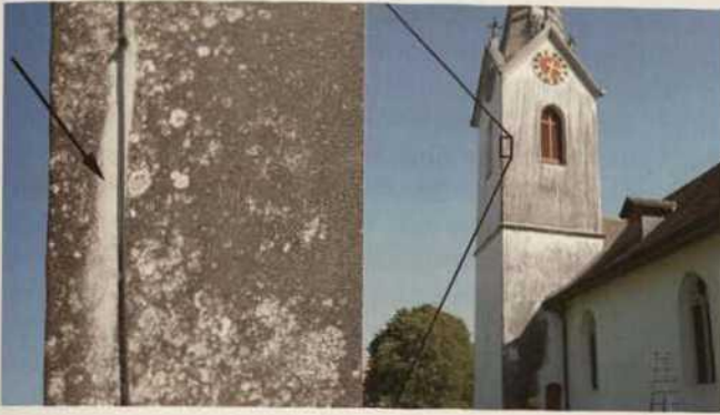
Abb. 9a-b. Westfassade eines zuletzt 1986 renovierten Kirchturms: Dunkle Verfärbung der hellen Tünche in den berechneten Bereichen (b), während im Regenschatten oder bei Kupferanteilen im Ablaufwasser der Bewuchs verhindert wird (a: Pfeil; Sommer 2004).
