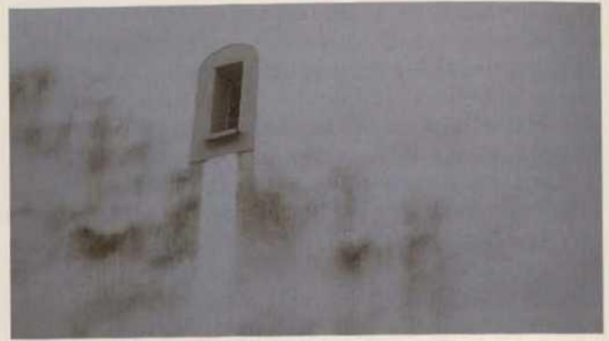
Abb. 8a. Nordfassade eines Kirchturms (s. Abb. 8b), Ausschnitt: Verschwärzungen nur an leicht nach oben geneigten Stellen des unebenen Fassadenputzes; fehlender Bewuchs im Regenschatten des kleinen Fensterblechs (20.3.2003).
