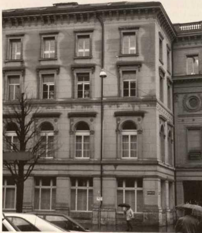
Abb. 1. Bern, Bundesgasse 8, nach Norden exponierte regennasse Fassade aus Berner Sandstein (15.2.1990) mit sichtbar dunkleren Stellen, an denen die Steine oberflächlich nass sind: zum einen direkt beregnete Flächen, zum anderen Bereiche, an denen das Wasser durch Fugen oder Risse in den Gesimsen kanalisiert abfließt.
