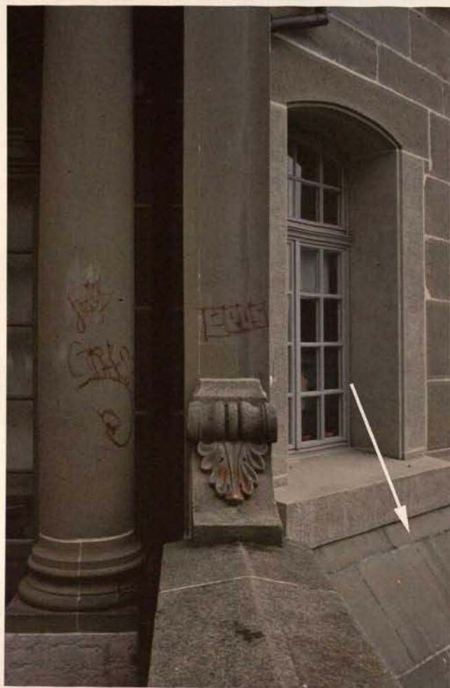
Abb. 11. Bern, Südwestecke der Münsterplattform, Pavillon (13.10.1994): 1987 gefestigte und hydrophobierte Fläche mit ersten Ansätzen einer Verdunkelung durch Bewuchs (Pfeil; vgl. Abb. 12).
