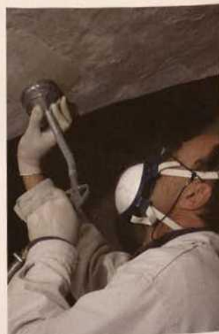
Abb. 12a-b. Quedlinburg, Stiftskirche St. Servatius, Krypta, Wandmalerei: Extraktion der Kunststoffbeschichtung durch Vakuumbehandlung (nach M. Lehmann).
