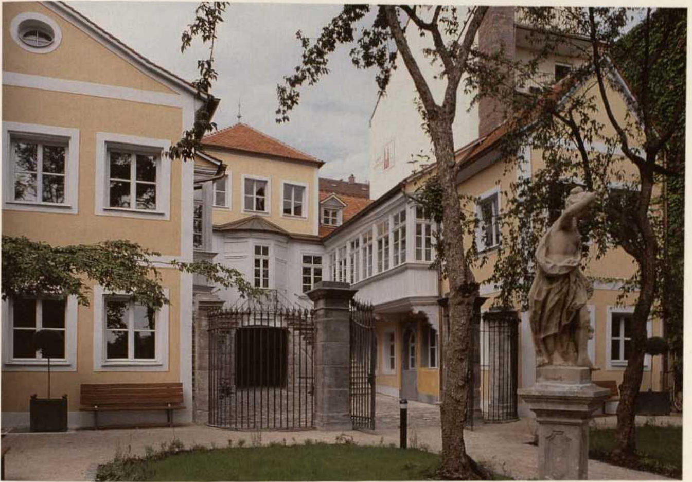
Abb. 4. Nürnberg, Johannisstraße 19, Südfassade mit West- und Ostflügel nach der Instandsetzung (2000).
