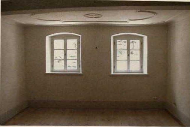
Abb. 21. Kucha, Haus Nr. 18, Mühlengebäude, Erdgeschoss: Stube nach der Instandsetzung (2003).
