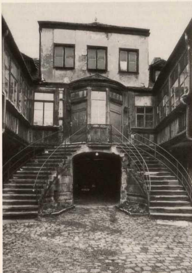
Abb. 2. Nürnberg, Johannisstraße 19, Südfassade vor der Instandsetzung (1997).
