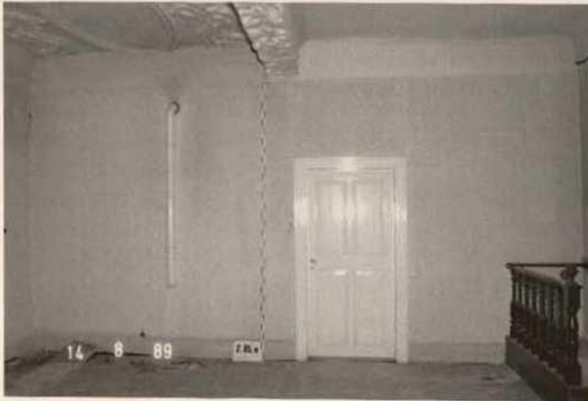
Abb. 12. Fürth, Königstraße 89, zweites Obergeschoss, stuckierter Raum vor der Instandsetzung (1989).
