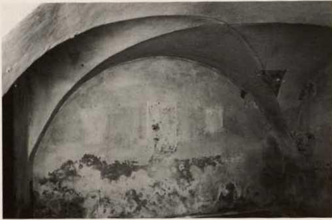
Abb. 17. Kucha, Haus Nr. 18, Mühlengebäude, Erdgeschoss: gewölbte Kammer vor der Instandsetzung (2000).
