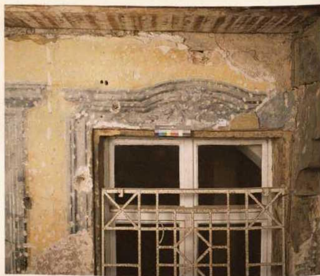
Abb. 3. Nürnberg, Johannisstraße 19, Westfassade des Ostflügels, Detail: unter vollflächiger Überputzung vorgefundener Bestand der Fassadenbemalung von 1727 (Zustand 1998).
