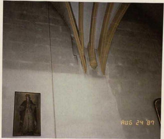
Abb. 8. Starke Verschmutzung der Raumschale infolge zu kalter Wandoberfläche, verdeutlicht am Unterschied des geringen Verschmutzungsgrads im Bereich der angebauten und damit „wärmenden“ Sakristei.
