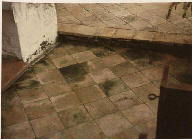
Abb. 7. Praktischer Nachweis des „Wassergewinns“ bei falscher Lüftung zur falschen Zeit.
