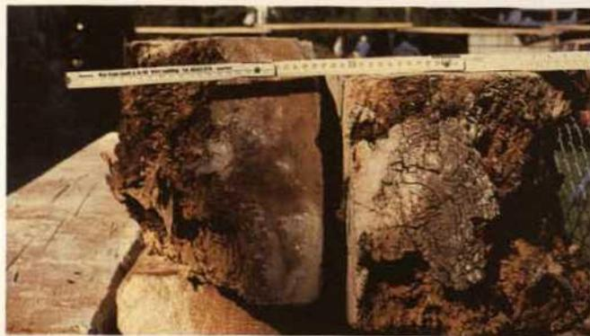
Abb. 3. Infolge Kondensation zerstörter Holzbalkenkopf einer Saaldecke.
