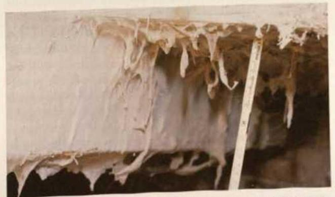
Abb. 5. Luftfeuchtebedingter Bauschaden: schwammbefallene Deckenkonstruktion.
