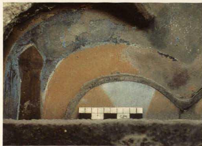
Abb. 2. Schwäbisch Gmünd, Heilig-Kreuz-Münster, Fenster nV, außen: Vorsicherung (in situ) der gefährdeten blauen Emailfarbe mit Paraloid B 72 (2001).
