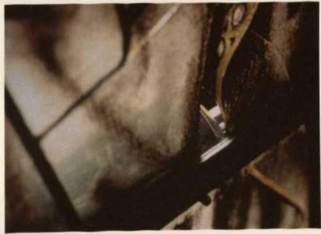
Abb. 7. Trier, St. Matthias, Chorfenster, Feld 2c, Detail: ursprünglich verklebte Glasscherbe gekippt (2003).
