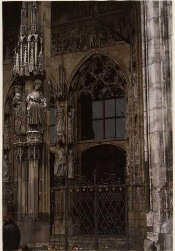
Abb. 11. Ulm, Münster, Westportalfenster: Einbau der neuen Schutzverglasung (2003).
