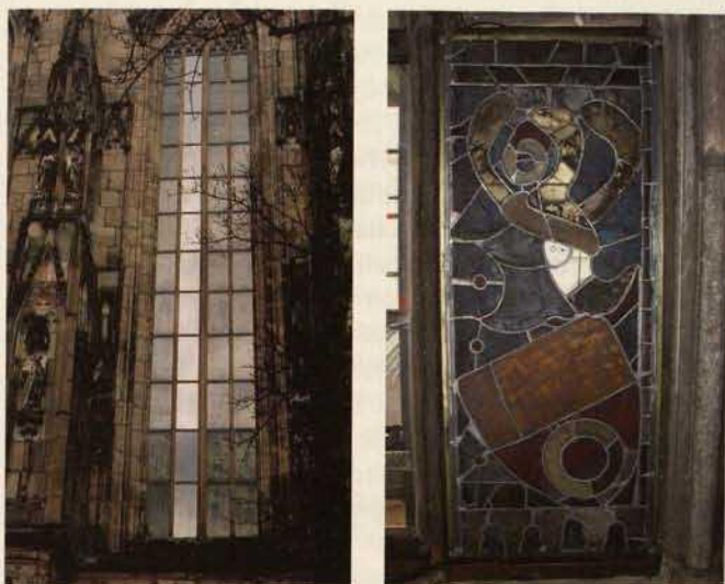
Abb. 25a-b. Nürnberg, St. Sebald, Fenster sV und nIV: Reflexionswirkung einer außen angebrachten Sonnenschutzfolie (a) und Verlegung eines elektrischen Heizkabels zur Spalttemperierung (b).
