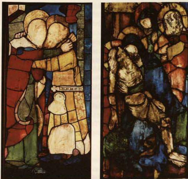
Abb. 11a-b. Nürnberg, St. Sebald, Fenster nVI (Mendel-Fenster), Scheibe 2c, Begegnung an der goldenen Pforte: weniger Glaskorrosion als auf der Südseite, aber nahezu kompletter Malschichtverlust (a); Fenster sV (Schürstab-Fenster), Scheibe 3b, Beweinung Christi: umfangreiche Malschichtverluste und stark korrodierte Oberflächen (b).
