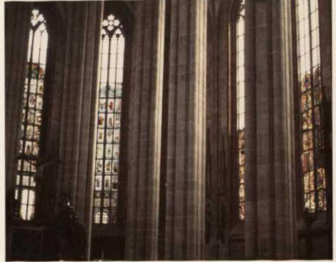
Abb. 24. Nürnberg, St. Sebald, Blick in den Hallenchor.
