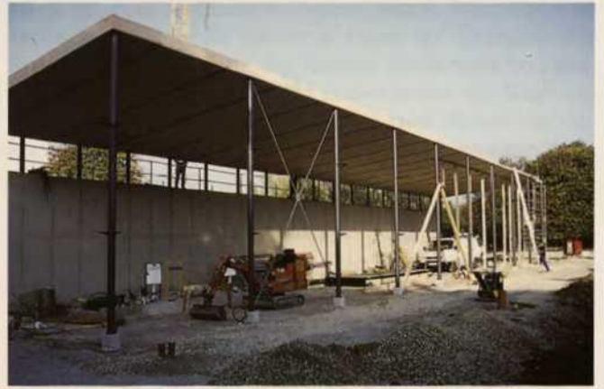
Abb. 6 Das Citrushaus im Bau, September 2001
