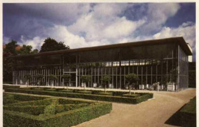
Abb. 8 Südseite des Citrushauses
