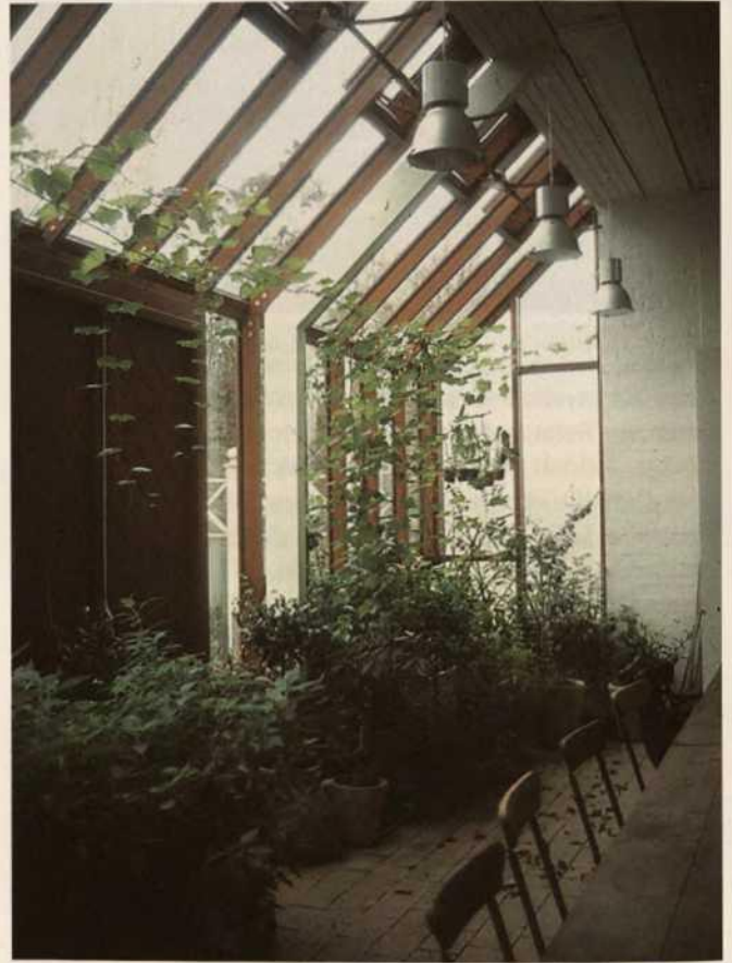
Abb. 6 Die Stahlkonstruktion mit den oberen Lüftungsfenstern; in der Decke die dünnen Warmwasserelemente
