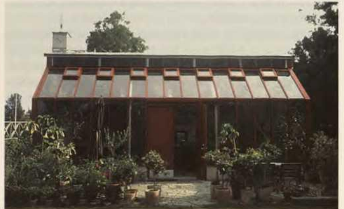
Abb. 5 Über den Oberfenstern der Südwestseite die vorderen Lüftungsschlitze zum Dachraum
