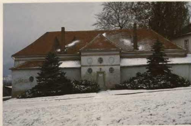
Abb. 6 Altmorschen-Haydau, Orangerie Nordseite, Foto Balsam 1990
