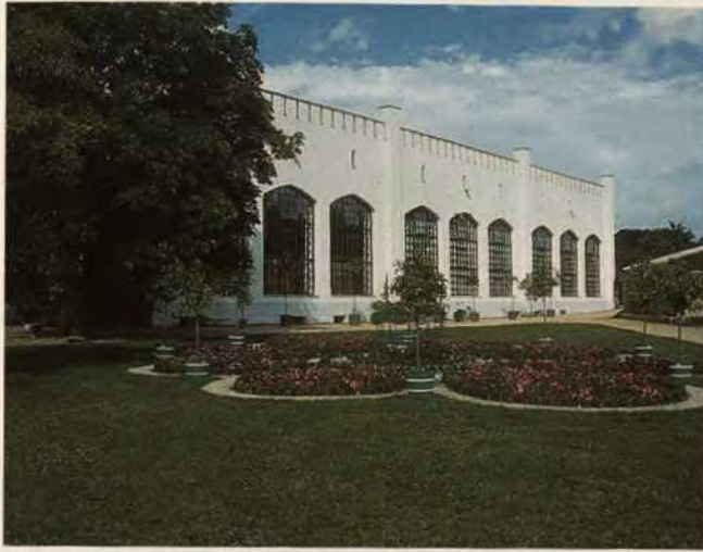
Abb. 15 Bad Muskau, Orangerie, Foto Balsam 2004
