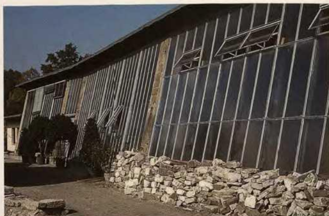
Abb. 3 Residenz Würzburg, Historische Glashäuser im Südost-Garten, Foto Balsam 1990
