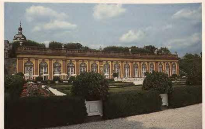
Abb. 8 Weilburg an der Lahn, Terrassenorangerie, Foto Balsam 1995
