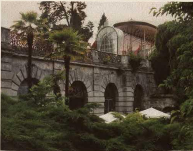
Abb. 12 Ansicht der Arkade, Nordseite, Foto: R. S. Dornbusch, 2001
