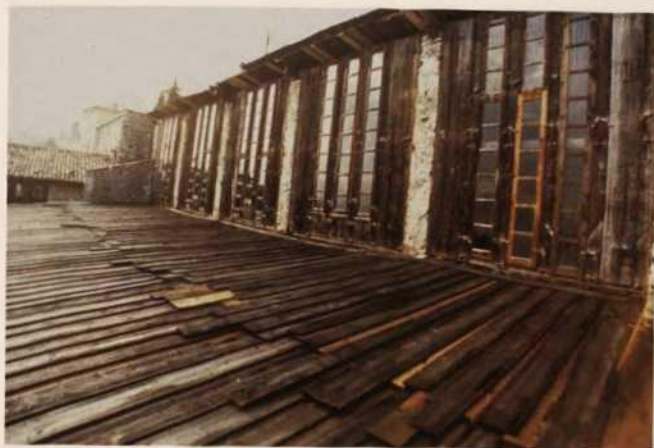
Fig. 4 Particolare dei serramenti e del tetto – di notevole interesse storico – della limonaia Gandossi a Gargnano, ancora conservata e in uso (foto di A. Cazzani, 1988)
