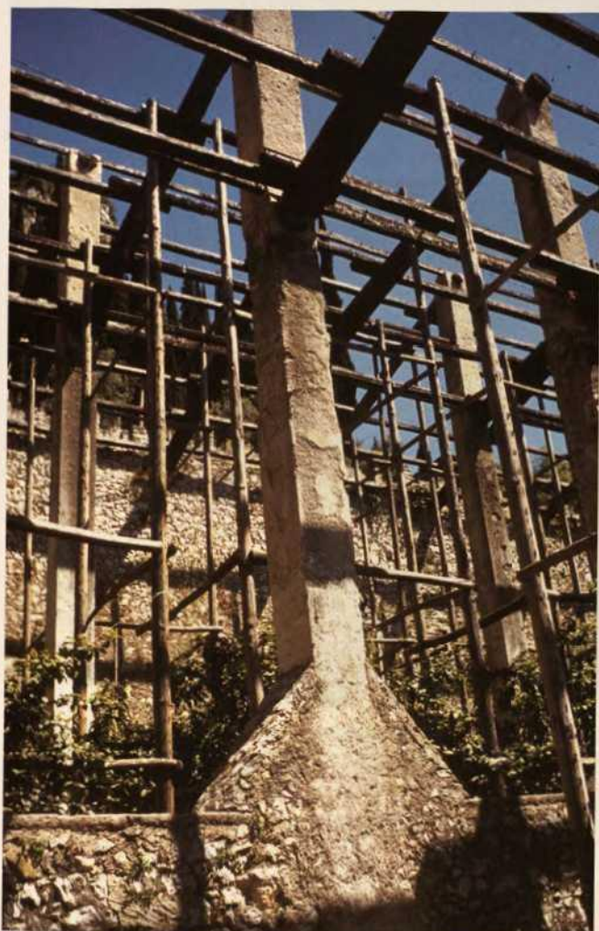
Fig. 5 Particolare del fronte delle limonaie del Prato della Fame nella versione estiva: si può notare la struttura lignea fissa della copertura (foto di A. Cazzani, 2003)
