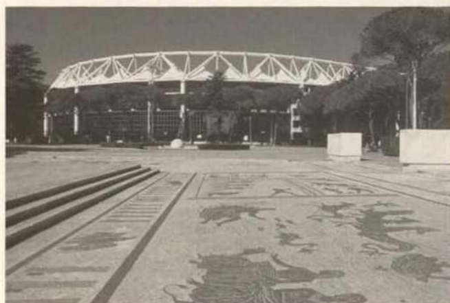
Fig. 4: The mosaics of the esplanade, called "Piazzale dell'Impero", ending with the circular "Fontana della Sfera". In the background the external ring of the reticular trusses of the Stadio Olimpico.
