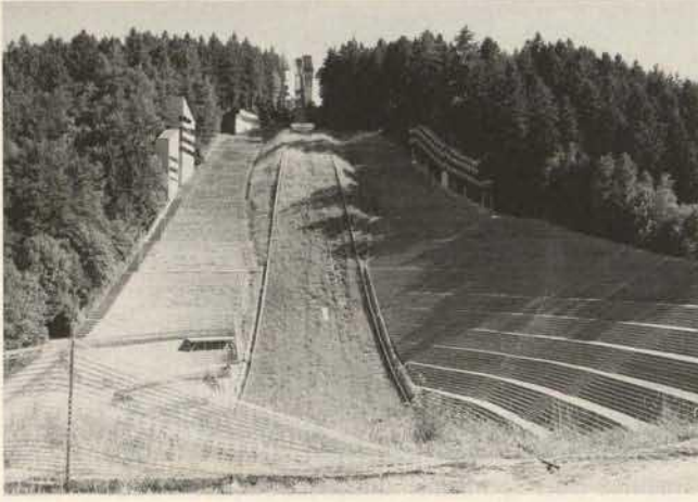
Abb. 1: Heinrich Klopfer, Oskar Heinz, Hans Buchrainer, Spezialsprungsschanze am Innsbrucker Bergisel, 1964, Zustand nach zahlreichen Um- und Zubauten an der Schanze; vor der Sprengung 2001
