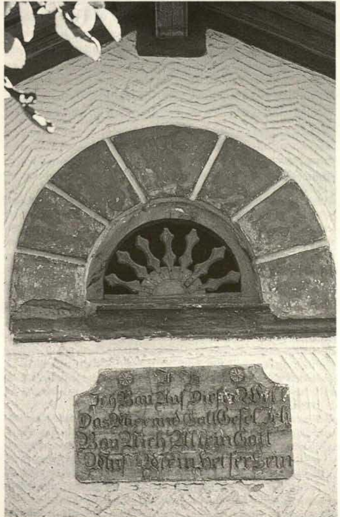
Abb. 20. Wolfhaming, Gde. Oberbergkirchen, Lkr. Mühldorf, Vierseitshof, Westtrakt, Nordgiebel, 19. Jahrhundert, Fischgrätmuster des Flächenputzes (Foto: Paul Werner)
