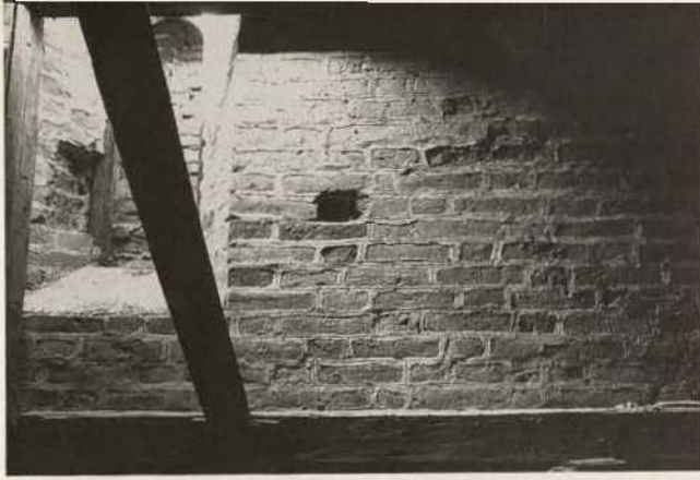
Abb. 4. Moosburg, Lkr. Freising, St. Kastulus, Südwand jetzt im Dachbereich der Ursulakapelle, Ende 12. Jahrhundert, additiv aufgesetzter weißlicher feiner Mörtel mit schmaler Fugenritzung (Foto: Mader)
