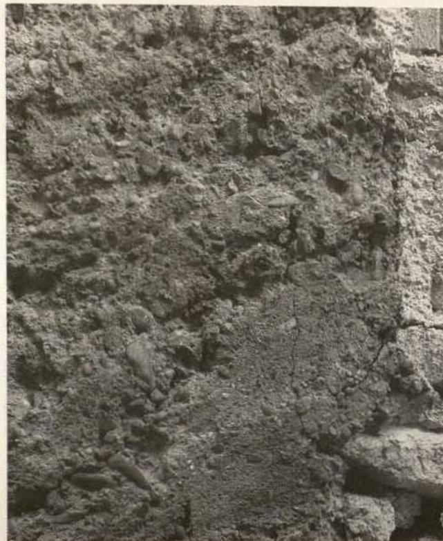
Abb. 6. Regensburg, Engelburgergasse 13, einfacher Kellenwurf, unten rechts leicht angedrückt, Überkorn ca. vier Zentimeter (Foto: Meixner)
