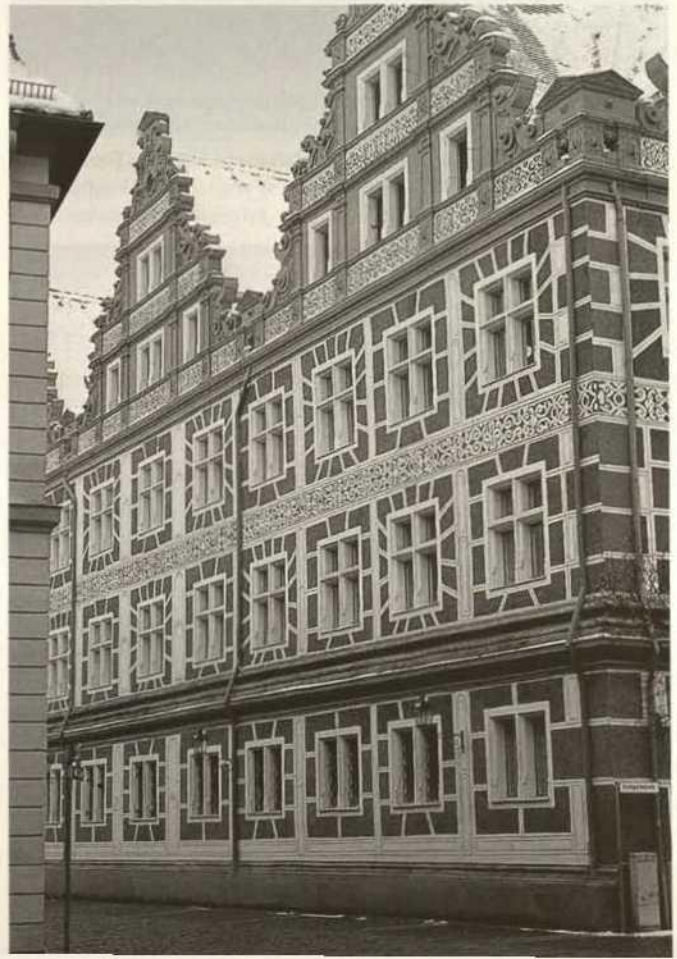
Abb. 12. Ansbach, ehem. Markgräfl. Kanzlei, Gideon Bacher 1594, jetzt schwarz gestrichener Stupfputz der Fensterrustika (Foto: Pursche)
