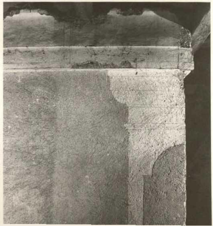
Abb. 18. Weyarn, ehem. Augustiner-Chorherren-Stiftskirche, ca. 1693 durch den Graubündner L. Sciasca, mit der Kellenkante abgezogene Putzfläche, Gliederungen vogeritzt, freskal kalkweiß getüncht, dabei Reduzierung der Putzrauigkeit (Foto: Pursche)
