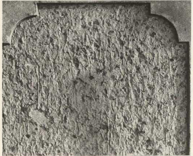
Abb. 19. Ebrach, Lkr. Bamberg, ehem. Zisterzienserkloster, südöstl. Hof, Ostfassade, 1698/1716 (Johann Leonhard Dientzenhofer/Joseph Greising, Balthasar Neumann), ursprünglich grau durchgefärbter, flüssig-sämig applizierter Putz, tränenartiger Verlauf („Tränenputz“), aufgeworfener Glasbruch von Butzenscheiben, gelbe und rote Farbtupfer (hier nur noch in den geschützteren Randbereichen) (Foto: Pursche)
