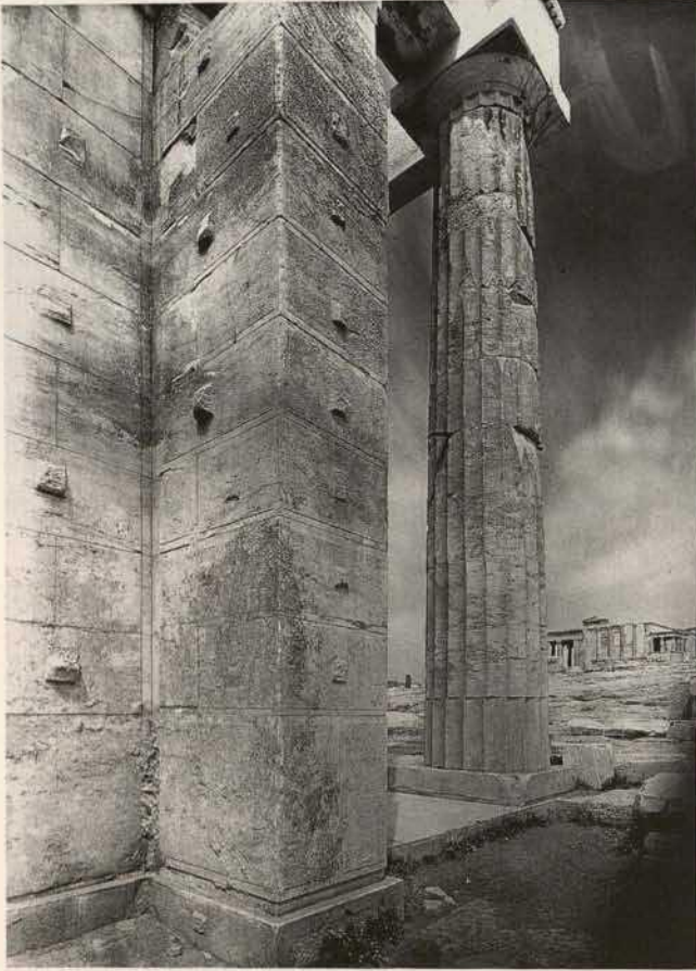
Abb. 7. Athen, Akropolis, Propyläen, unfertige Quaderwand (Foto Hege, DAI Athen)
