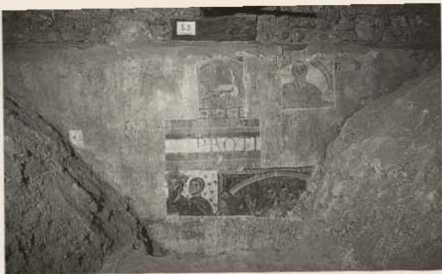
Abb. 11. Aosta, Cattedrale, Mittelschiff (Dachraum, Südseite), Freilegung Juli 1988
