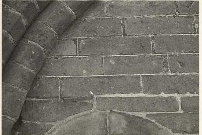
Abb. 9. Monza, Arengario, außen, Ostseite, Tympanon der 1. Trifora (von N), Reste von Fugenmalerei auf ursprünglich ganz bemalten Backsteinen (Juli 1985)
