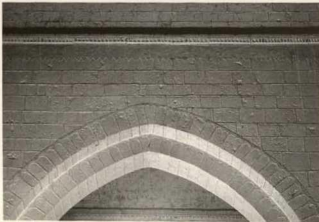
Abb. 15. Cadouin (Périgord), ehem. Zisterzienserkirche, Innenraum, Arkadenzone im 2. Joch (von Osten) des Mittelschiffes, Südseite, Putz- und Fugenmuster (Sept. 2003)
