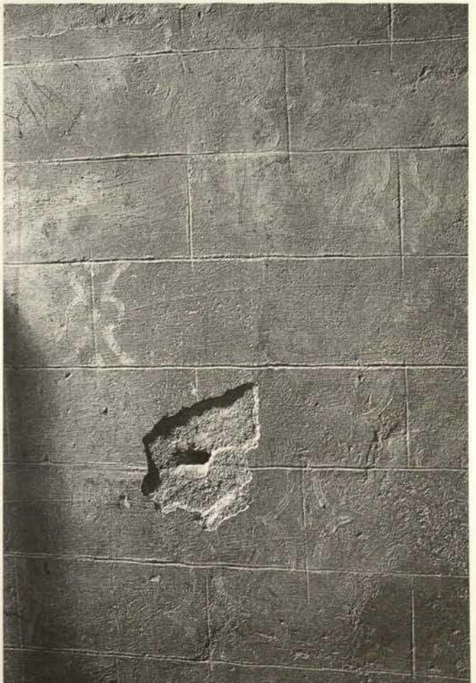
Abb. 10. San Benedetto Po (Mantua), Klosterkirche, Obergaden, ursprünglich Außenbau, heute Dachraum, Fugenmalerei auf Putz (Aug. 1981)
