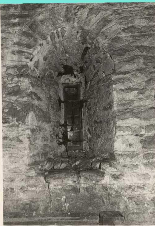
Abb. 3. Solnhofen, Turminneres der ehem. Probsteikirche (Foto: Institut für Ur- und Frühgeschichte der Universität Heidelberg)
