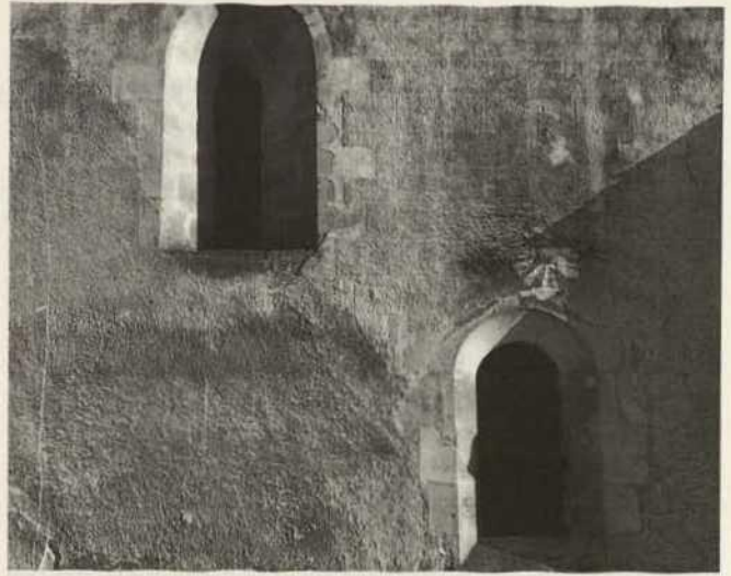
Abb. 3. PROVERVILLE, Kirche St. Genest (12.–16. Jh.), Langhaus, Nordfassade: Fugenmalerei um die Fenster auf geglättetem Putz; auf der Wandfläche rauer Putz (leichtes Relief) mit tieferliegenden Fugen
