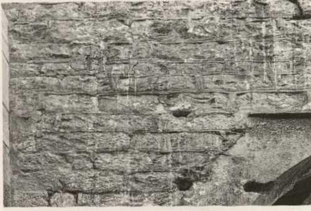
Abb. 1. CLAIRVAUX, Zisterzienser-Kloster (Mitte 12. Jh.), Gebäude der Konversen, Ostfassade: Bandfugen, sehr wahrscheinlich aus der Zeit des Originalbaus. Reste eines ockergelben Putzes sind unter späteren Schichten sichtbar
