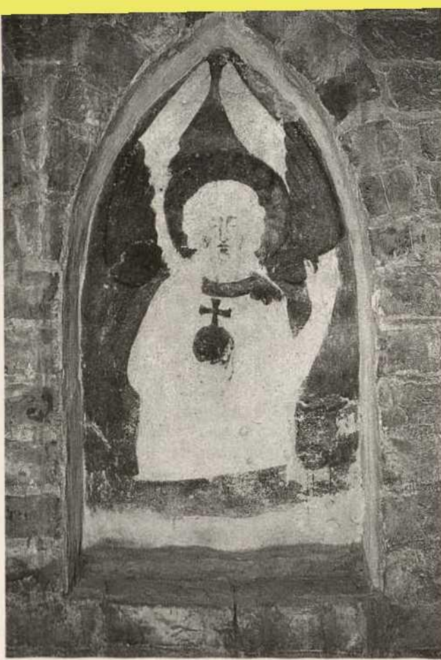
Abb. 4. Frankfurt/Oder, Nikolai-, heute Friedenskirche, Detail des Ostgiebels, Nische mit Malerei eines Engels der Zeit um 1300; Zustand nach Reinigung und Malschichtsicherung 1999 (Foto: J. Raue)
