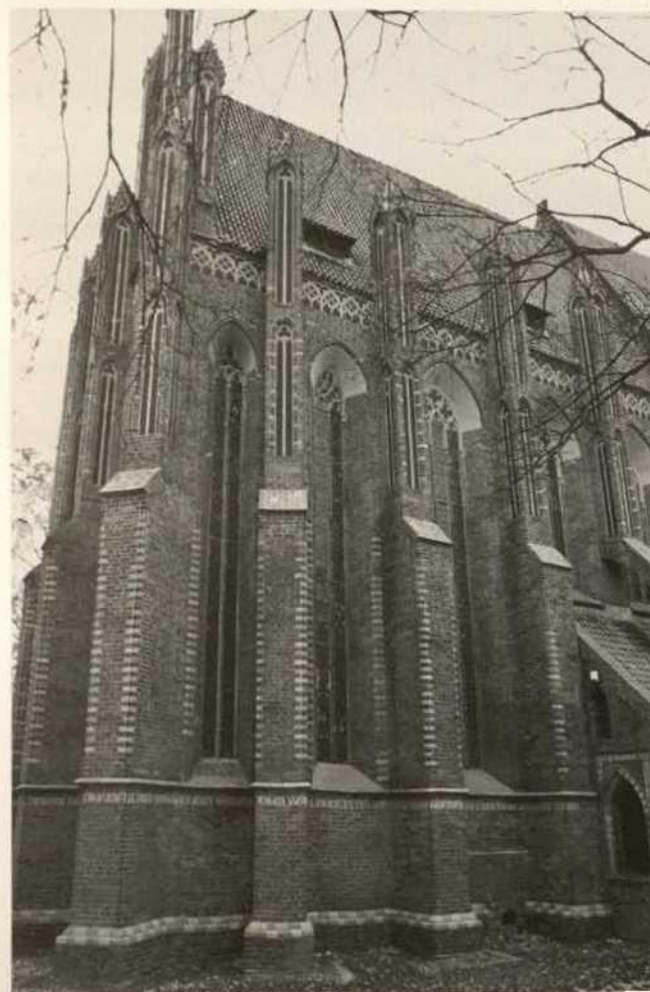
Abb. 4. Thorn, Jacobikirche, Chor von der Nordostseite, Zustand 2001 (nach Restaurierung) (Foto: Pospieszny)
