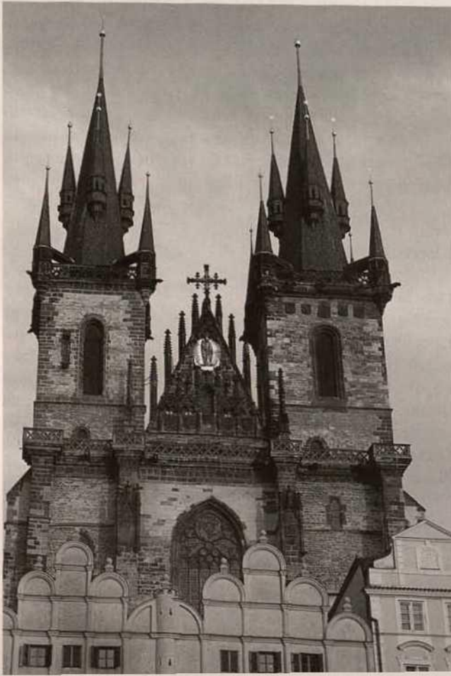
Abb. 4. Prag, Tejnkirche am Altstädter Ring, Türme in altdeutscher Schieferdeckung (Foto: Roland Möller)
