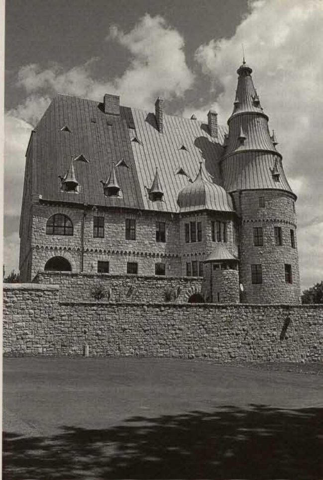
Abb. 6. Ohrdruf, Schloss Mühlburg, errichtet nach Plänen von Bodo Ebhardt (1933-1935). Aufnahme zeigt die unterschiedliche Wirkung des grünen Kupferdaches und dessen Ausbesserung in noch nicht patiniertem Kupfer (Foto: Roland Möller)
