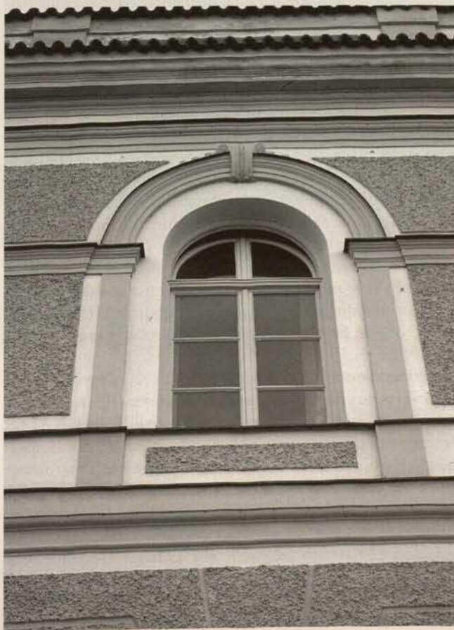
Abb. 2. Schloss Nymphenburg, Marstallbau, Fassadendetail, 2002 (Foto Staschull)
