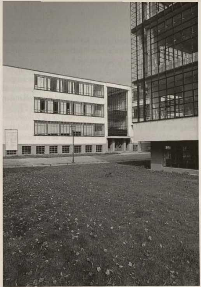
Abb. 7. Dessau, Bauhaus-Werkstättentrakt, rekonstruierte Vorhangfassade von 1976 aus Aluminium und Glas, die Geschossdecken wurden ganz an die Fassade herangeführt (Foto: Georg Mörsch, 2002).
