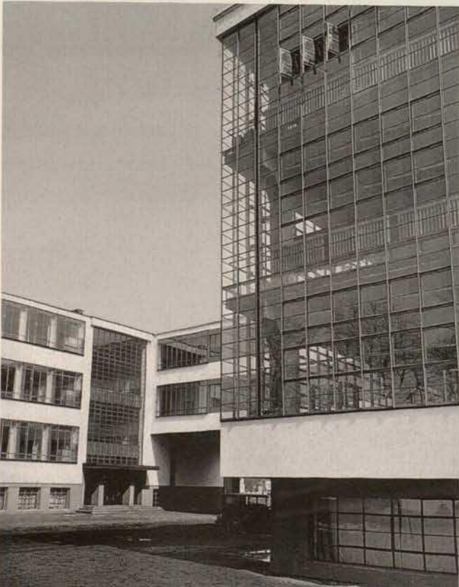
Abb. 6. Dessau, Bauhaus-Werkstättentrakt, ehem. „freie“ Ecke der Vorhangfassade aus Stahl und Glas
