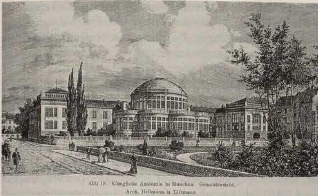
Abb. 1. Das erste Sichtbetongebäude in München: Anatomiegebäude der Universität München, Pettenkoflerstraße, von Max Littmann (1905–07) (aus: E. von Mécenseffy, Die künstlerische Gestaltung der Eisenbetonbauten . Erster Ergänzungsband des Handbuchs für Eisenbetonbau. Berlin 1911)
