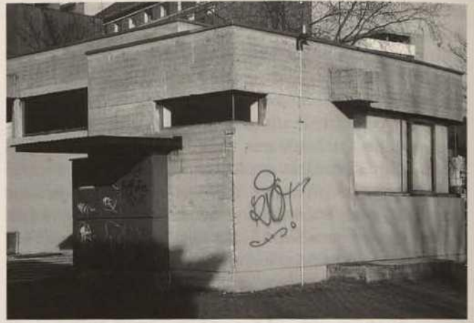
Abb. 16. RWTH Aachen, Pförtnerhaus, schadhafte Sichtbetonflächen, die untere Brüstungsfläche gestrichen (Foto H. Schmidt)
