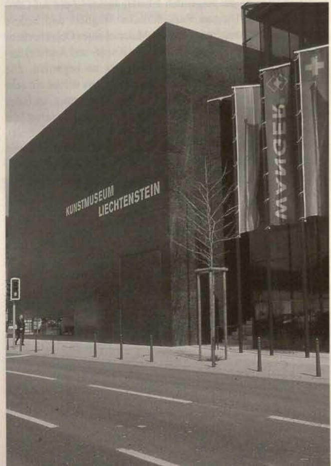
Abb. 19. Geschliffene und polierte Sichtbetonfassade des Kunstmuseums Liechtenstein (1998–2000) von Morger, Degelo und Kerenz (Basel/Zürich) (Foto H. Schmidt)
