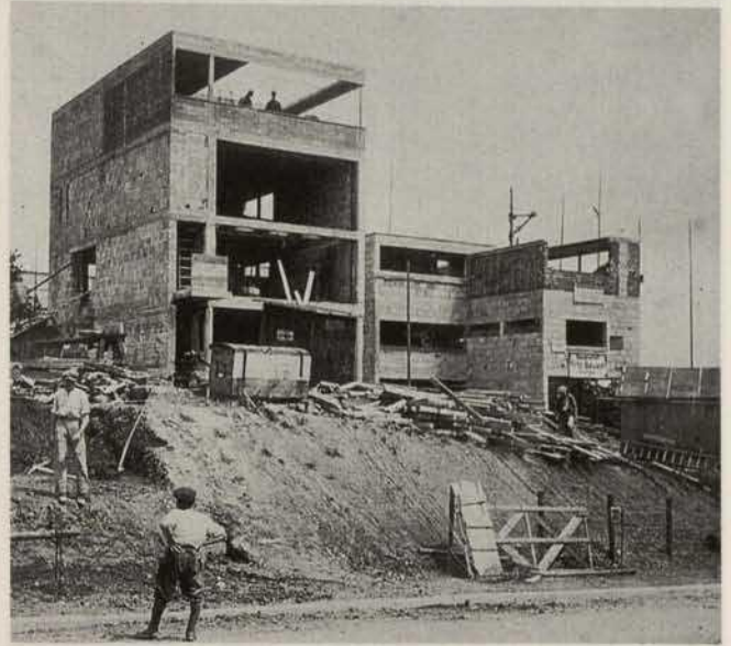
Abb. 11. Zwei Wohnhäuser von Le Corbusier und Pierre Jeanneret auf der Werkbundausstellung 1927 in Stuttgart-Weissenhof im Rohbau (aus: Karin Kirsch, Die Weissenhofsiedlung , Stuttgart 1987)
