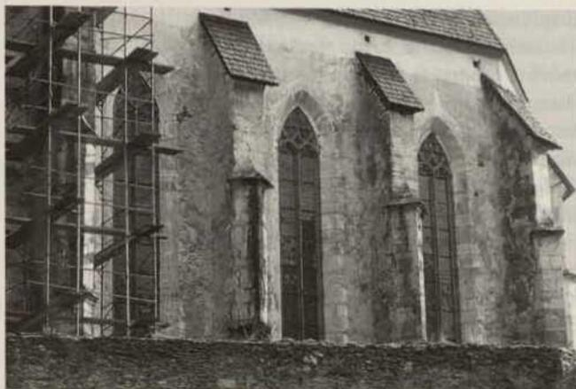
Abb. 3. Grades, Wallfahrtskirche St. Wolfgang (1453–74), Chor, Südfassade, Spuren der Wiederverwendung der Netzriegellöcher für Reparaturgerüste (Foto: Hammer 1986)
