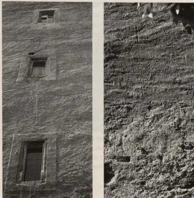
Abb. 1 a, b. Krems/Niederösterreich, Passauer Hof, Turm, ursprünglicher Verputz 15. Jh., einschichtig auf Bruchsteinmauerwerk, rau abgezogen und abgekellt, regelmäßige Fugenmalerei; a. Gerüstgrenzen, Fächerstruktur; b. Detail: Faktur, Überlagerung von 4 Texturen: Maueroberfläche, Kellenabzug, Abkellen, Fugenmalerei (Fotos: Hammer 1979)
