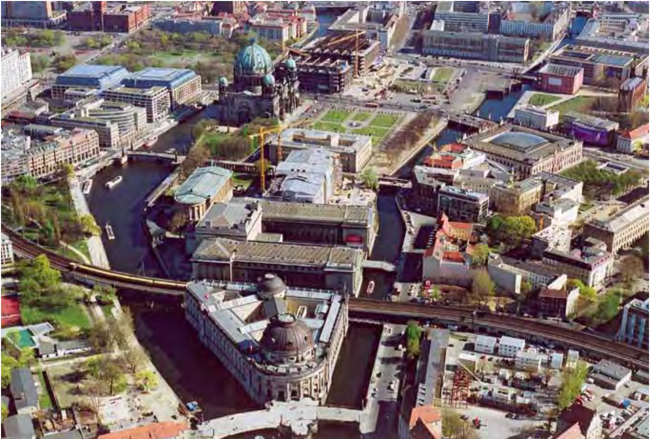
Museumsinsel, Gesamtansicht, Zustand 2009 Остров Музеев, общий вид, состояние в 2009 г.
