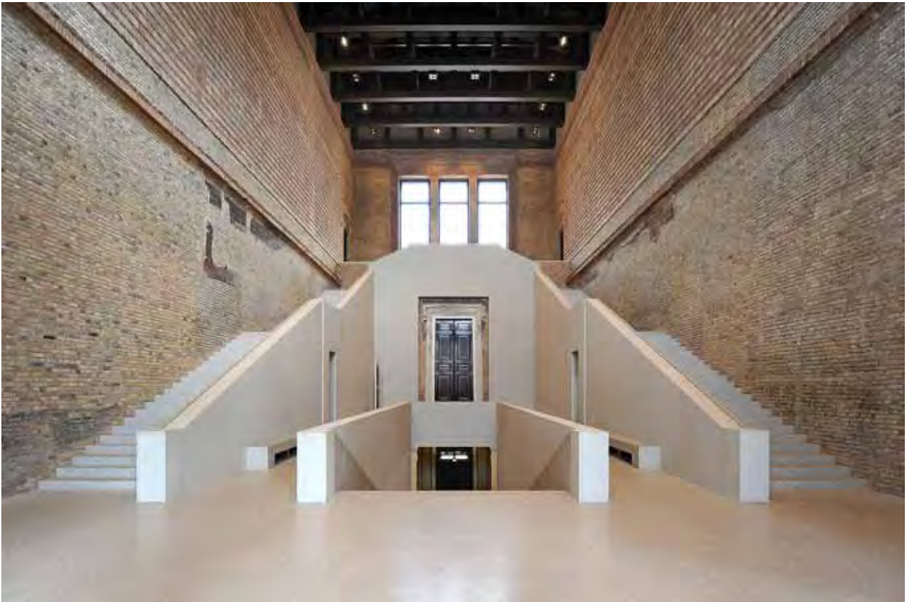
Neues Museum, kriegszerstörtes Treppenhaus mit neu eingebauter Treppenanlage Новый Музей, разрушенная войной лестничная клетка с новой лестницей
