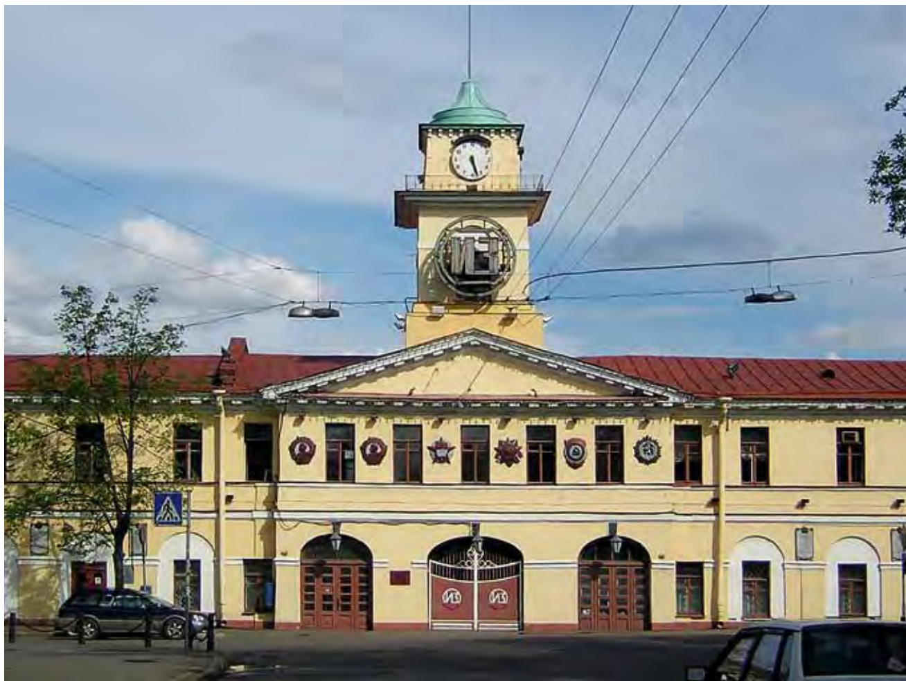
Заводоуправление Ижорского завода в г. Колпино. Leitungsgebäude des Ižorskiy Betriebs in der Stadt Kolpino.
