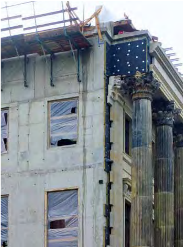
Die Fassade des neu erbauten Braunschweiger Schlosses besteht aus einer Betonkonstruktion mit Sandsteinverkleidung – Vorbild für die übrigen Neubauschlösser in Potsdam, Berlin und anderswo?
