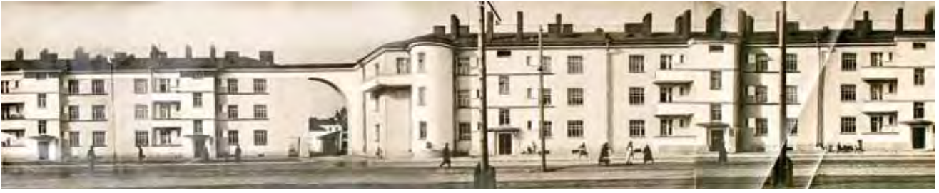
Застройка Серафимовского участка (1925–1928. Архитекторы Александр Гегелло, Александр Никольский, Григорий Симонов). Фотография 1935.
