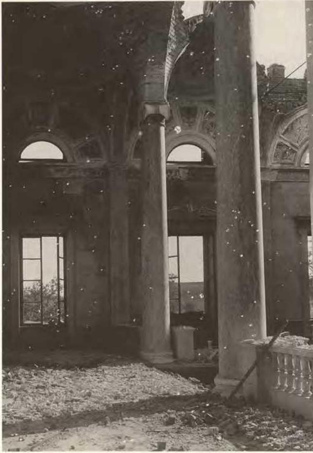
Abb. 16. Das nördliche Raumkompartiment im Hauptgeschoß der Festsaaltrappe zeigt um 1947 deutliche Spuren des Verfalls. Dennoch ist mit den (wie die Treppenläufe) stabilen Säulen, großen Teilen der Wandgestaltung und verbliebenen originalen Fensterflügeln noch ein überraschend großer Rest des klassizistischen Raumkunstwerks erhalten. Es wurde wenig später für den Theater einbau und weitere Umgestaltungen des Festsaalbaus geopfert.
