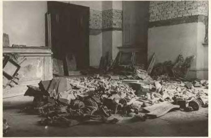
Abb. 6. Fragmente der Logenarchitektur des Residenztheaters im Zustand vor der Neuverleimung. Die Aufnahme entstand im Frühsommer 1956 in Schloß Lustheim bei Schleißheim. Links ist eine der im Kern stabil gebliebenen Brüstungen des zweiten Ranges sichtbar.
