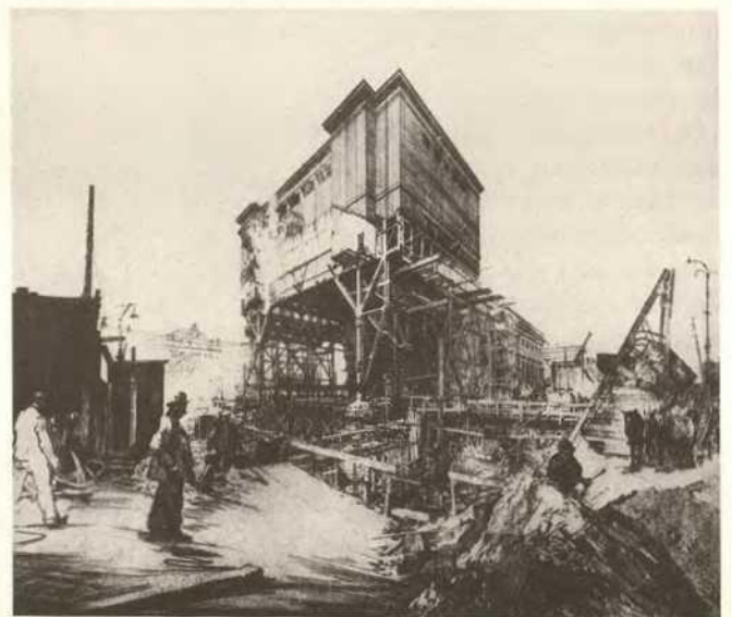
Abb. 7. Paul Hermann, Umbau des Knobelsdorffschen Opernhauses 1926/27 mit Abriß des ursprünglichen Bühnenbauteils unter Beibehaltung des Bühnenturms von 1911/12
