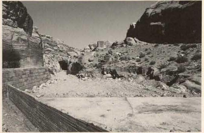
Abb. 5. Am linken Bildrand der Damm vor dem Eingang in den Siq, dahinter die Öffnung des nabatäischen Tunnels für die Ableitung des Wassers
