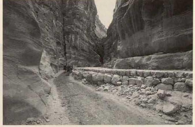
Abb. 16. Siq, Unterbau der Straßenpflasterung
