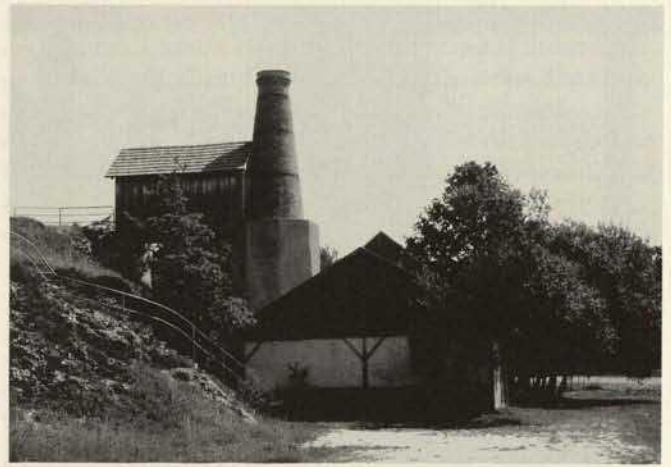
Abb. 10. Untermarchtal (Baden-Württemberg). Der 1922 erbaute Kalkofen nach der Restaurierung 1986 und Umwandlung in ein Technikmuseum. Kalk wird hier nicht mehr gebrannt, doch ist der alte Ofen ein wichtiges Geschichtszeugnis.
