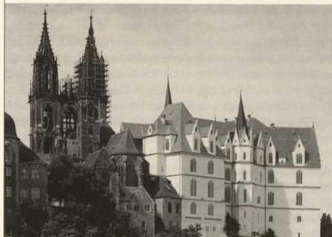
Abb. 13. Meissen (Sachsen). Die Albrechtsburg nach der Sanierung. Werbung der Firma Creaton mit dem eingedeckten Dach.
