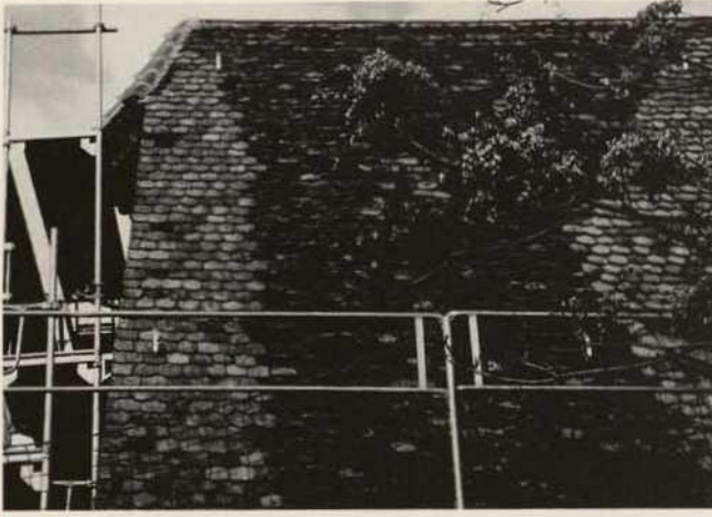
Abb. 8. Würzburg (Bayern). Die Reparaturmaßnahmen haben die Fläche der handgestrichenen Biberschwanzziegel wohl verringert, doch ist im Gegensatz zu einer vollständigen Neueindeckung die historische Kontinuität gewahrt.
