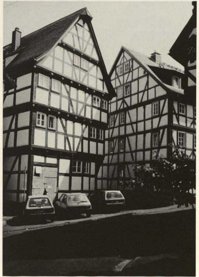
Abb. 4. Alsfeld. Das Fachwerkhaus nach Abschluß der Sanierung. Foto 1992
