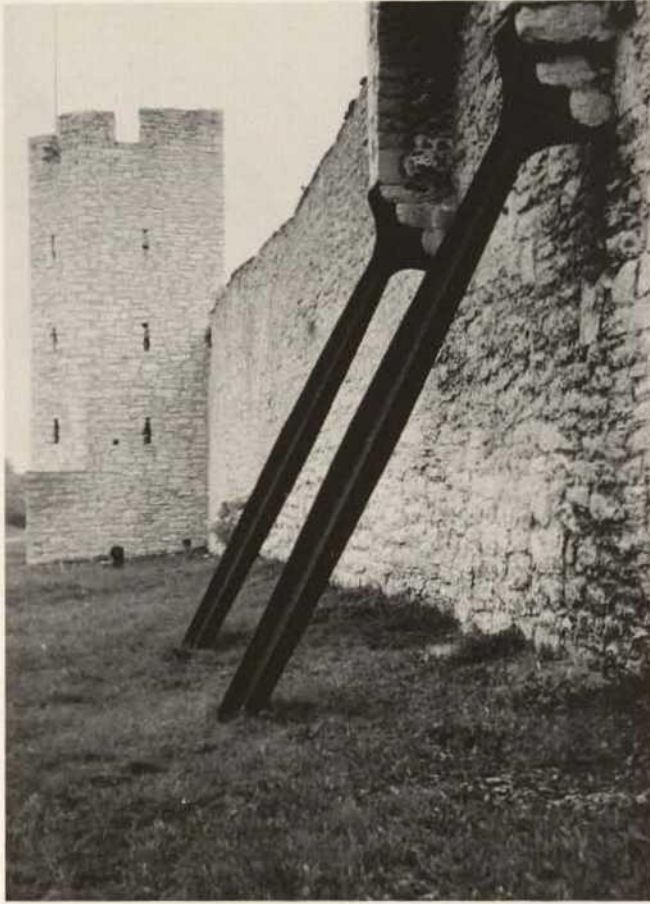
Abb. 5. Gotland (Schweden). Die mittelalterliche Stadtmauer von Visby. Gußeiserne Stützen zur Sicherung eines Zwischenturmes.
