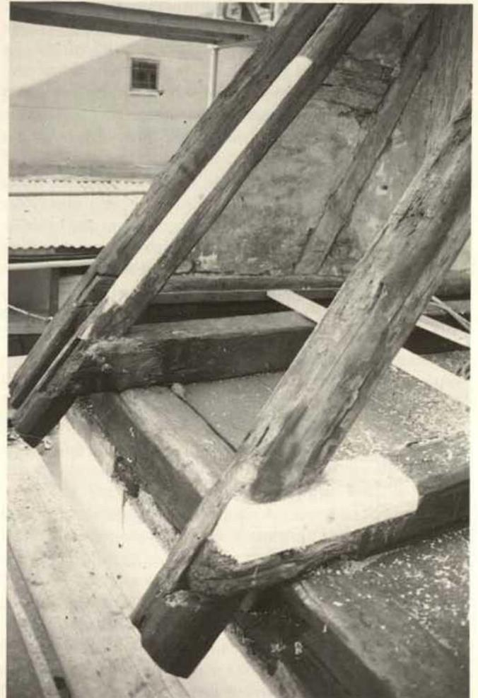
Abb. 16. Rein zimmermannsmäßige Reparatur des Fußes eines anderen Dachwerks von 1391(d) in Franken. Die Methode ist hier gerade noch vertretbar, wenn wenigstens die Hälfte des Knotens, das Bundzeichen und historische Aufschnürungen erhalten bleiben, die Anschlüsse an benachbarte Bauteile nicht zerstört werden und mehrere völlig intakte Dachfüße erhalten bleiben, die den konstruktiven Befund vollständig zeigen. >
