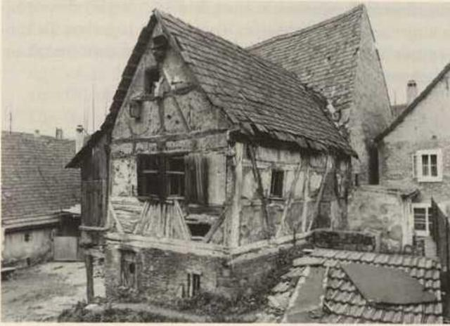
Abb. 3. Mainbernheim, Berggasse 6, Seitengebäude von 1593(i) von Osten, vor der Instandsetzung. Gemauerter Unterstock weitgehend original, Fachwerkwand Ost und Nord im 18./19. Jh. unter Verwendung vieler Altteile umgebaut. Photo 1977.
