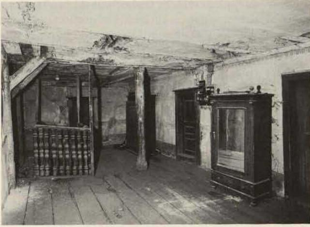
Abb. 1. Mainbernheim, Haus Beyer, Berggasse 6, Diele im Oberstock von 1591(i) mit zeitgleicher, geringfügig umgebauter Treppe sowie Türen aus verschiedenen Perioden, vor der Instandsetzung, 1977.
