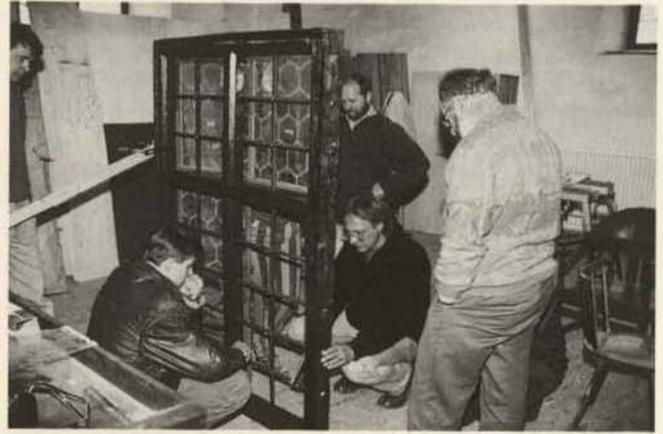
Abb. 10. Thierhaupten, Begutachtung einer Fensterstockreparatur während eines Handwerkerkurses mit Restaurator Martim Saar 1991. Inzwischen werden aufgrund erheblich gesteigener Erfahrung Fensterstöcke für die Reparatur kaum mehr ausgebaut.
