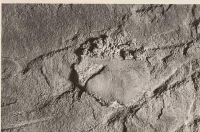
Abb. 19. Mörtelreste mit dem Abdruck eines textilen Musters Fig. 19. Mortar patches with textile impressions
