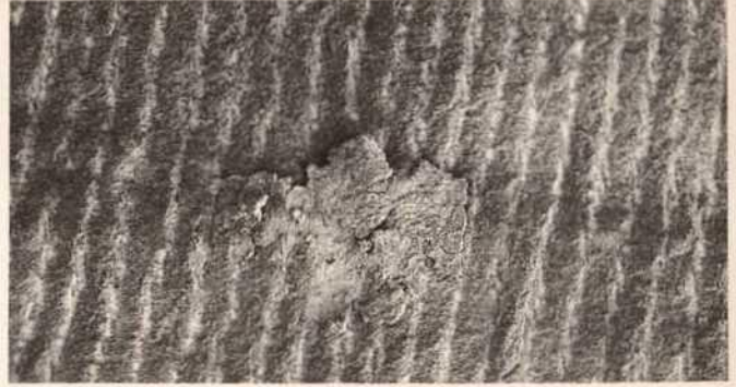
Abb. 28. Profilarbeitung mit dem Flacheisen Fig. 28. Dressing the profile with a flat chisel
