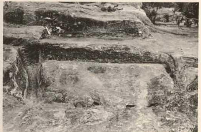
Abb. 4. Steinbruch im Wadi Siyyagh, Steinblock mit Keillöchern
