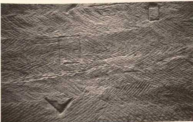
Abb. 13. Einsatz des Flacheisens an den Kanten Fig. 13. Working with a flat chisel on the edges
