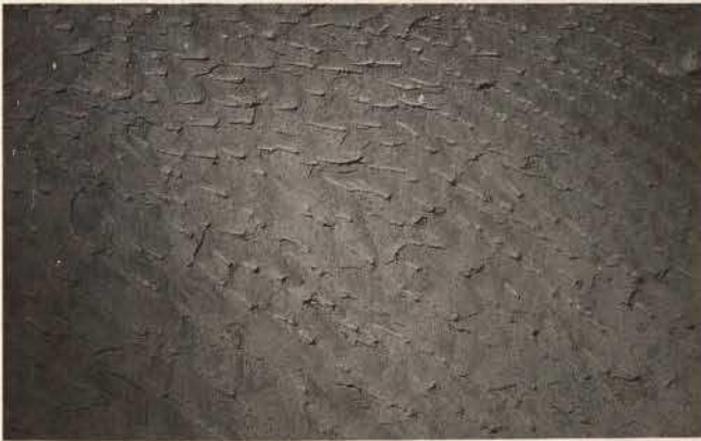
Abb. 11. Einsatz des Spitzeisens zur Ausarbeitung parallel liegender Diagonallinien Fig. 11. Dressing of parallel diagonal lines with a pointed chisel
