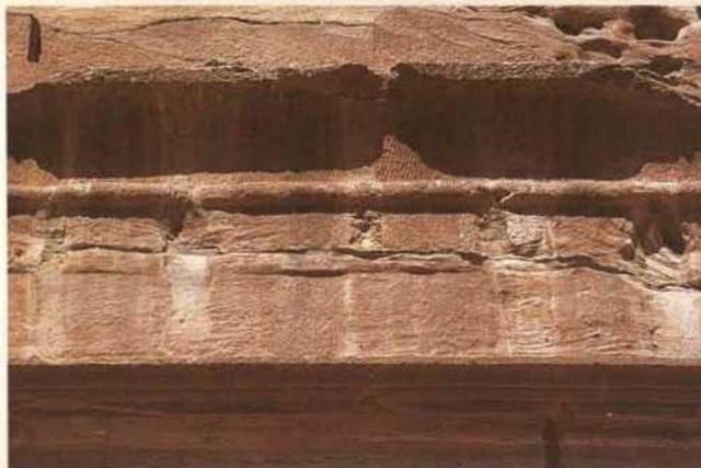
1 Sogenanntes Seidengrab, flächiger Massenabtrag durch Wassereinwirkung und Winderosion
