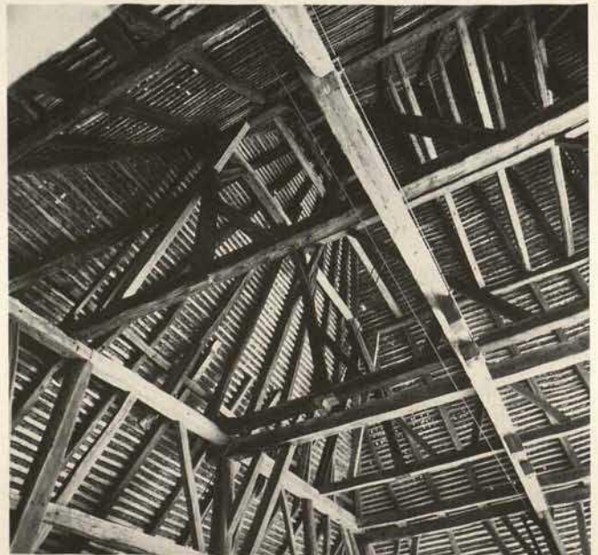
Abb. 20. Blick in den Dachraum. In Bildmitte ist die Abspannung der mittleren Stuhlsäule zu erkennen.
