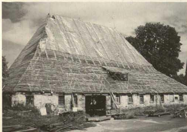
Abb. 4. Südseite des „Alten Bauhofs“ während der Instandsetzung.
