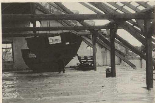
Abb. 6. Selektiver Rückbau eines Gebäudes
