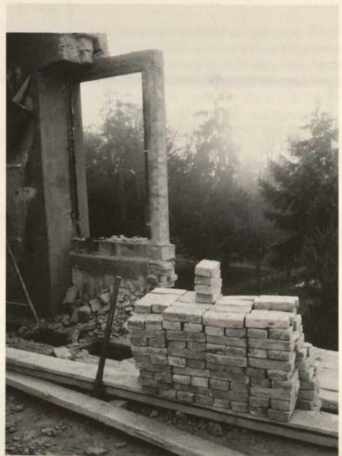
Abb. 12. Bergung von Mauerziegeln und Gewänden aus Sandstein
