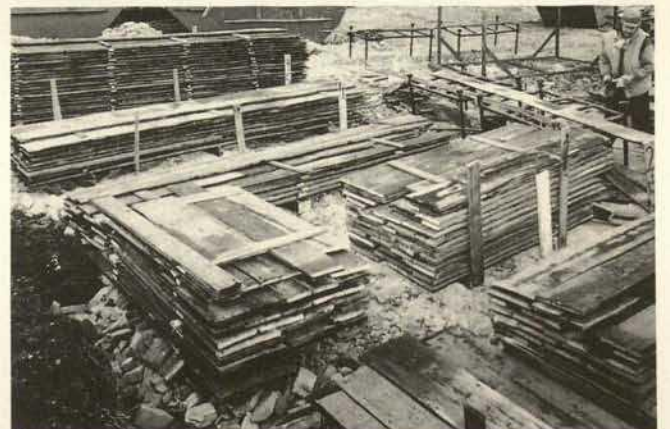
Abb. 15. Lagerplatz für Holzbauteile
