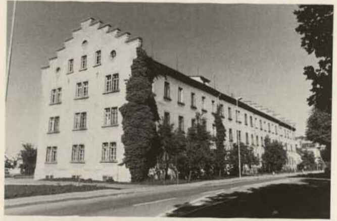
Abb. 8. Tabaklager Herbolzheim, Gesamtansicht
