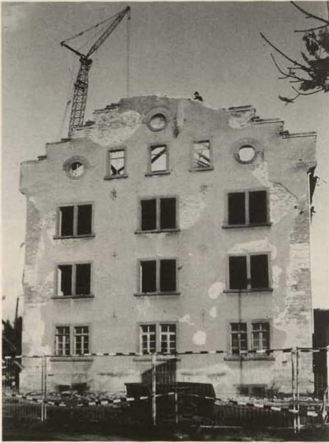
Abb. 10. Teilweise entkernter Giebel, Dachstuhl und Fenster
