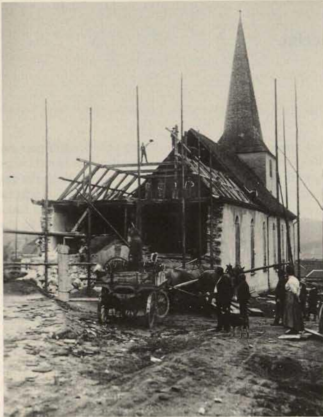
Abb. 2. Rückbau einer Kirche
