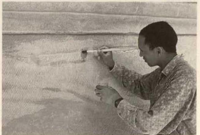
Abb. 10. Auftragen der Suspension bei der Retusche einer Reparaturstelle
