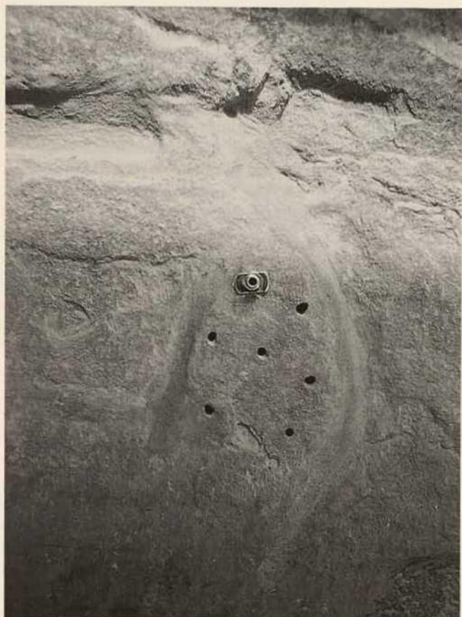
Abb. 14. Aufbringen der Packer auf die Injektagestelle mit Heißkleber Fig. 14. Application of 'nipples' (packer) at the hollow scale with hot adhesive paste
