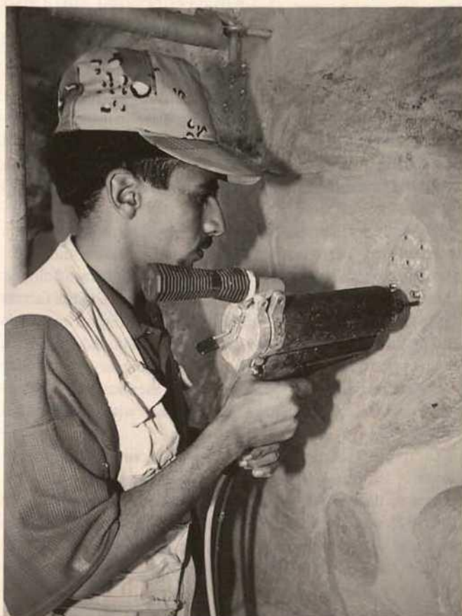
Abb. 13. Abgehobene Hohlstelle am Rande angeböschst und durch Bohrung zur Injektage vorbereitet Fig. 13. Scales with sloped rim prepared for injections by drilling
