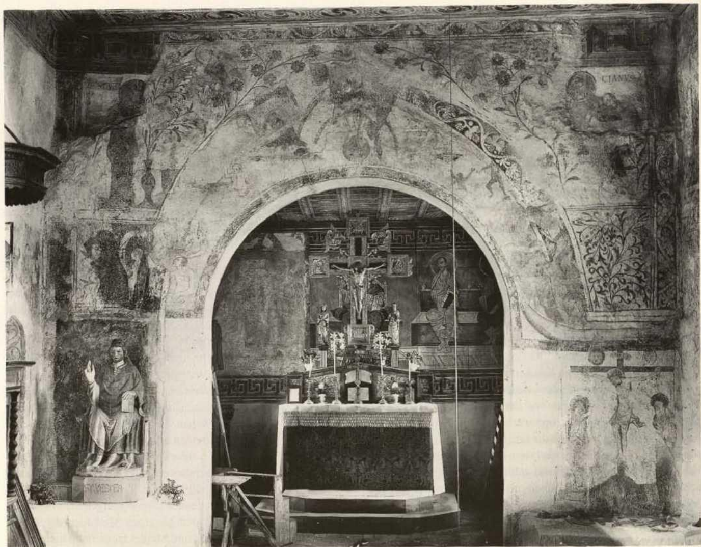
Abb. 59. Goldbach, Sylvesterkapelle, Ostwand des Schiffs und Blick in den Chor nach der Freilegung von 1905: verschiedene Ausmalungsphasen auf unterschiedlichen Mörtelniveaus (Zustand ca. 1920).
