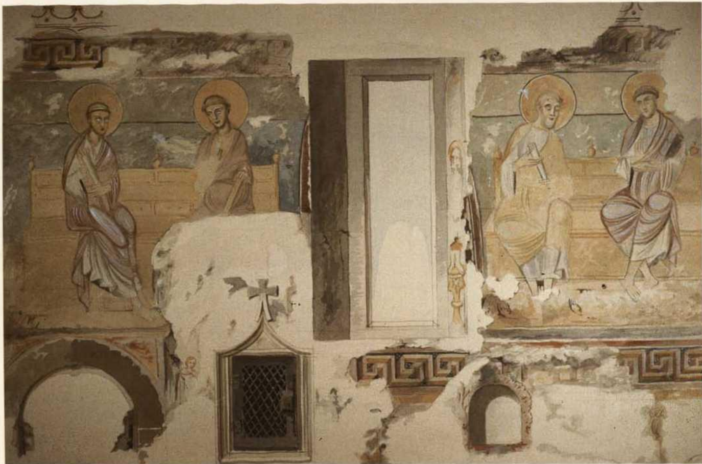
Abb. 68. Goldbach, Sylvesterkapelle, Chor, Nordwand: Dokumentation des Freilegungszustands durch Mezger, 1904.
