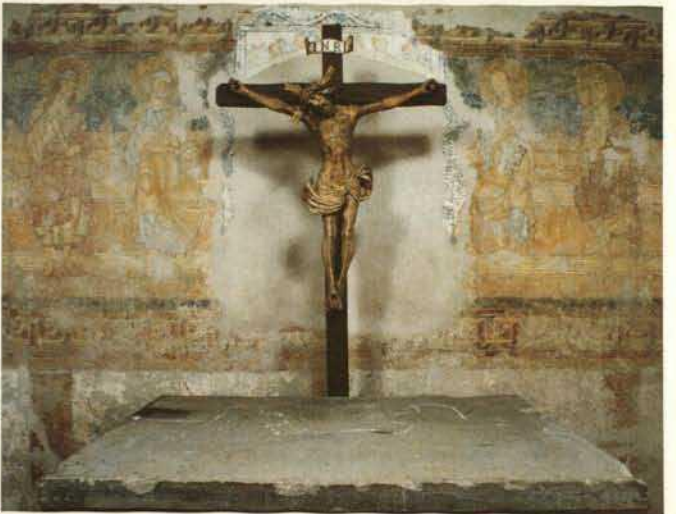
Abb. 67. Goldbach, Sylvesterkapelle, Chor, Ostwand nach der jüngsten Restaurierung (Zustand 1995).
