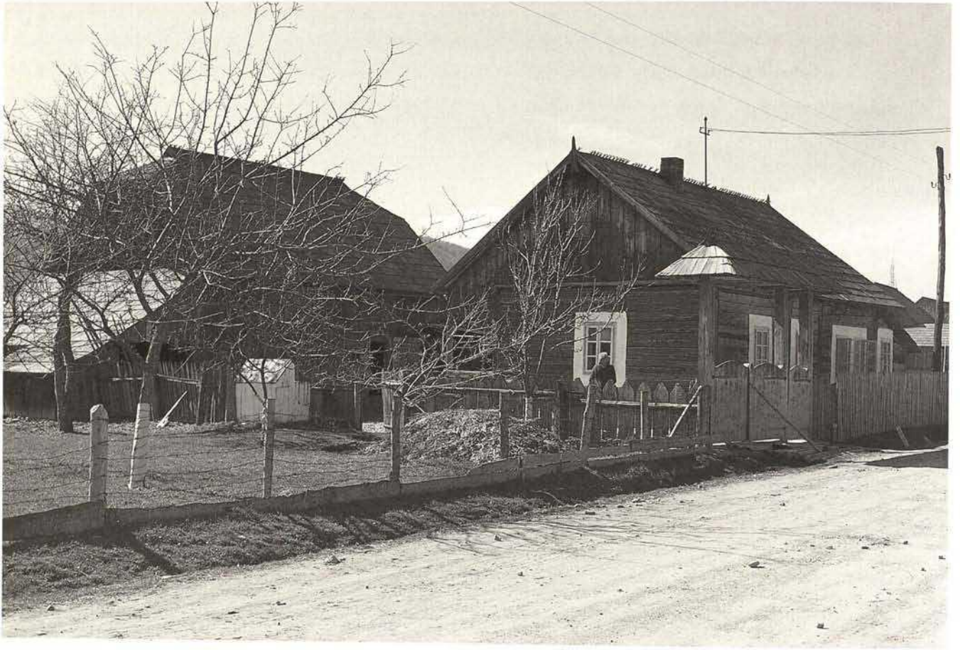
Moldavie du nord (près de Humor): ferme et grange roumaines, exemples de la construction traditionnelle en rondins. Northern Moldavia (near Humor): Romanian farm and barn showing traditional loghouse construction. Nordmoldau (bei Humor): rumänisches Gehöft in traditioneller Blockhausbauweise.
